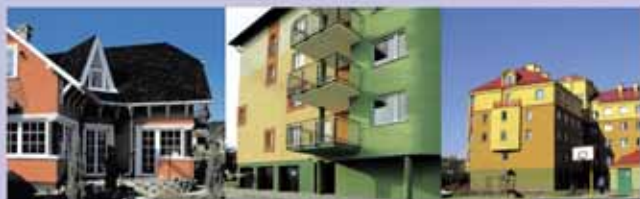
Elewacje wykonane w systemie Terranova
